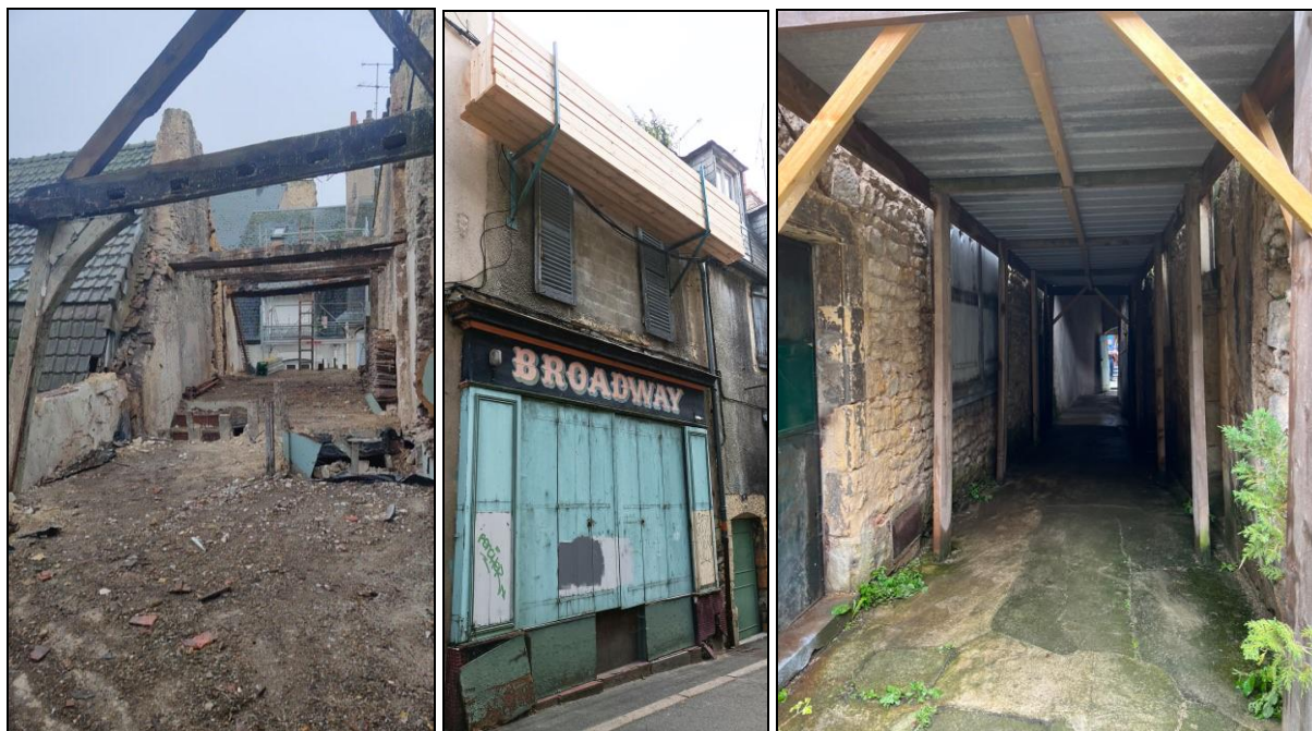
Photos des travaux effectués, à la suite du péril imminent.
