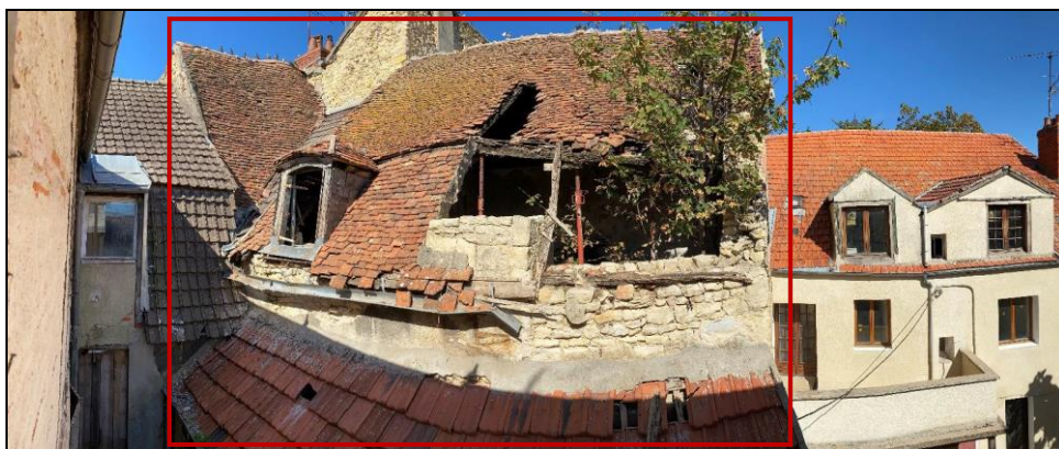
Photo prise depuis le R+2 du 5 rue du Fer
