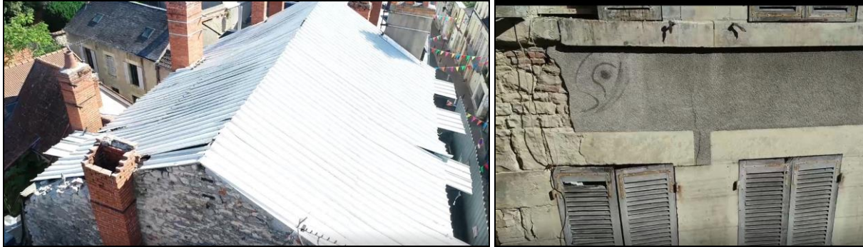
Photos de la couverture provisoire et de la façade sur rue.
